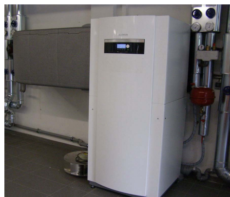
Obr.1 Kompaktní tepelné čerpadlo Logatherm WPL ve vnitřním provedení instalované ve výrobním závodě
