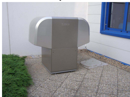
Obr. 2 Tepelné čerpadlo Logatherm WPL 10 A – Topenářské centrum Buderus, Praha
