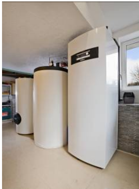
Obr. 2 Příklad instalace tepelného čerpadla Logatherm WPS 7 K se solárním předehřevem TV
